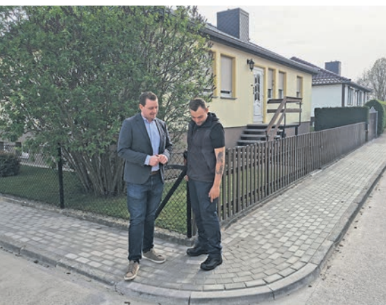
Bürgermeister Florian Schüler (CDU) und Lukas Winzer vom Bauunternehmen Winzer GmbH kontrollieren die ausgeführten Arbeiten
