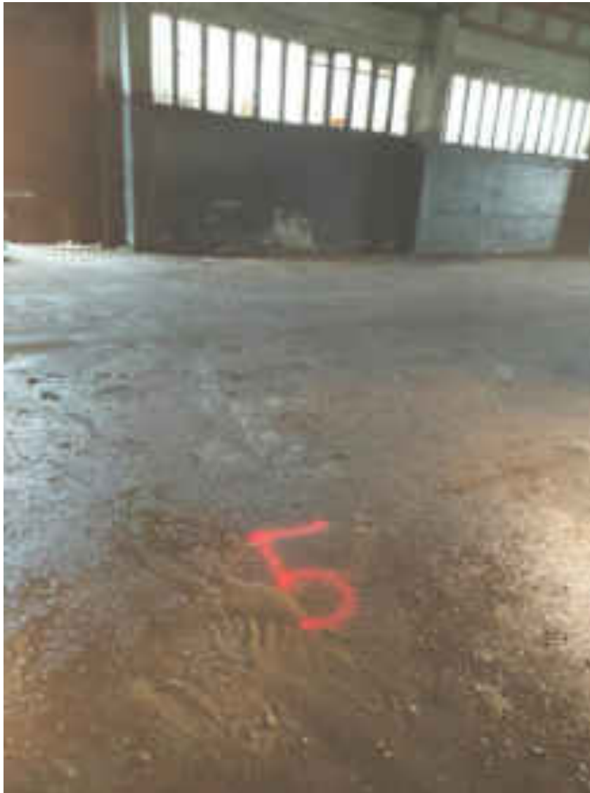
Abb. 5-2 Ansatzpunkt KRB-R5/21 und Blick auf die abgedichteten Lagerwände
