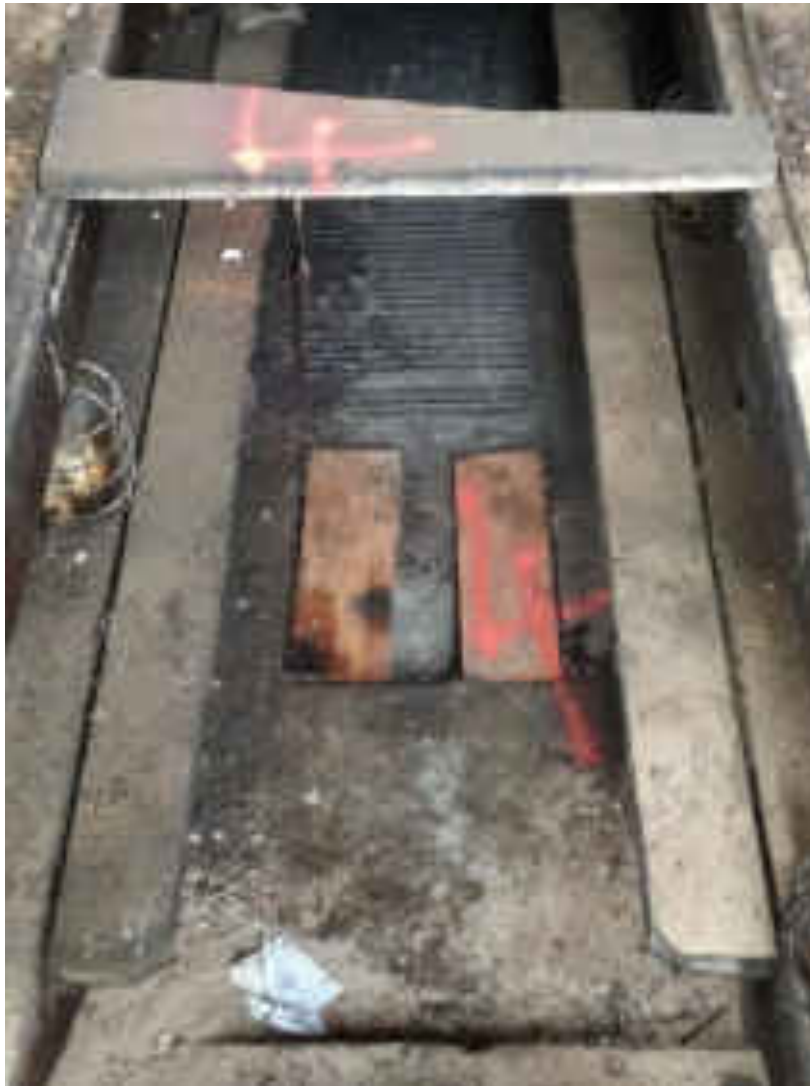
Abb. 5-1 Wartungsgrube im Bereich des ehemaligen Lokschuppens.
