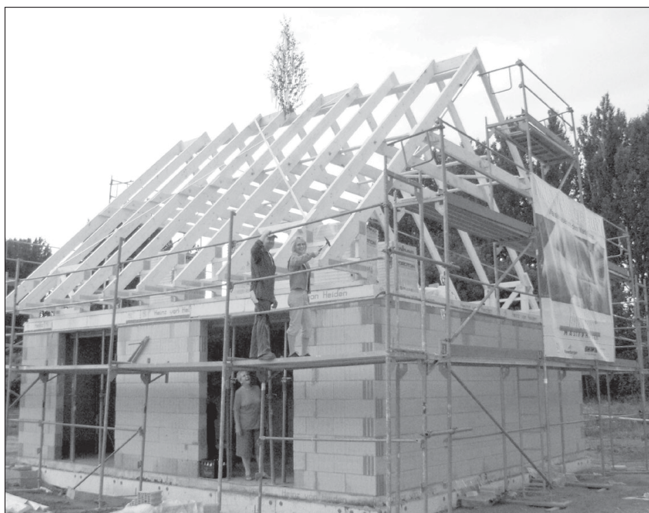
Die Familie Anke und Heintje Graneis konnten als erste Eigenheimbauer des Wohngebietes Ringstraße am 09.08.2006 Richtfest feiern.
