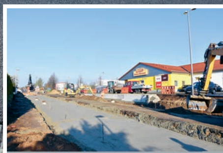
Bauarbeiten Golzener Straße
