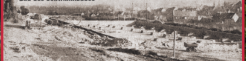
Bau des Schwimmbades
