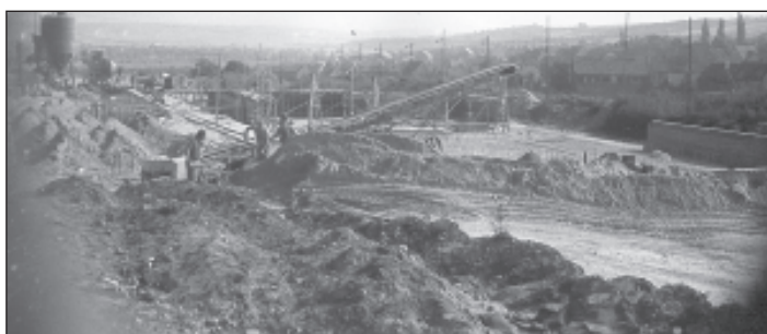
Erste Bauarbeiten im Jahre 1967
