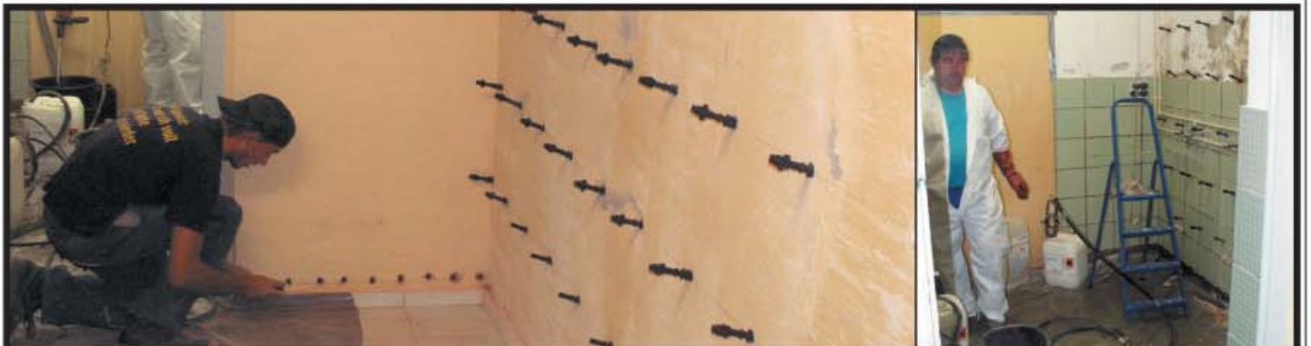
In der Grundschule Friedrich-Ludwig-Jahn in Freyburg (Unstrut) werden derzeit Trockenlegungsarbeiten durchgeführt. Anschließend werden die Fenster erneuert.
