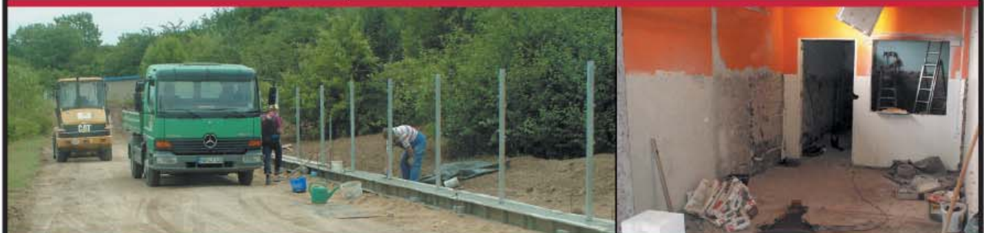
In der Ganztagschule in Nebra (Unstrut) werden die Sportanlagen sowie die Essenausgabe und das Behinderten-WC neu hergerichtet. Diese Maßnahme wird zu 90 % vom LSA durch das Investitionsprogramm Zukunft, Bildung und Betreuung finanziert.
