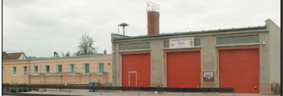
Am Gebäude der Freiwilligen Feuerwehr Laucha an der Unstrut werden derzeit Fassaden-, Dämmungs- und Dachsanierungsarbeiten durchgeführt. Die Maßnahmen werden durch Haushaltsreste zu 100 % von der Stadt finanziert.
