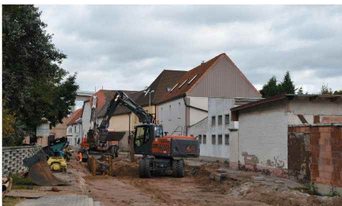
Landesstraße L 212 Ortsdurchfahrt Wetzendorf
